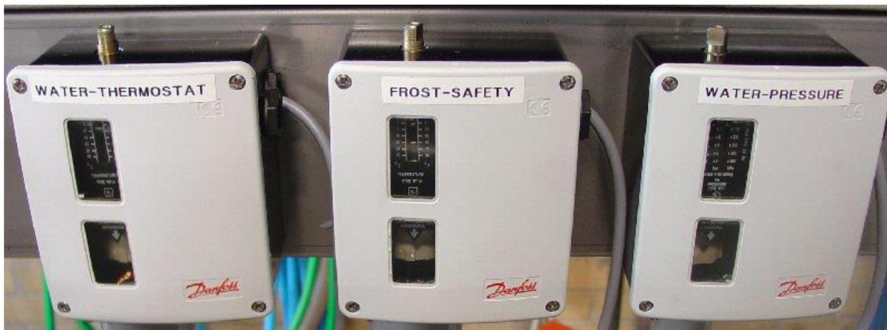
La machine à glace comporte deux thermostats et un régulateur de pression de sécurité.
