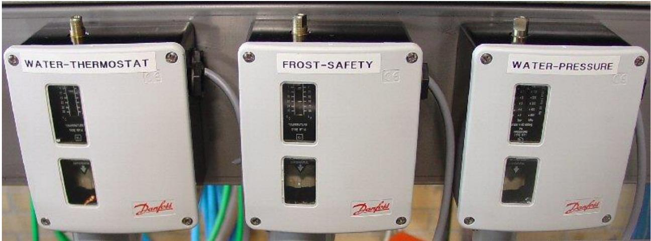
Die Eismaschine ist mit zwei Thermostaten und einem Sicherheitsdruckregler ausgestattet.
