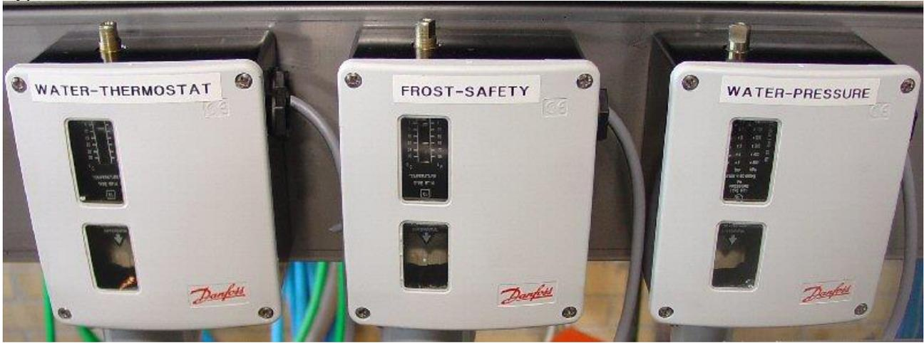
Einstellungen: Wärmeschutz (Water-Thermostat) , SP = +11 °C / +8 °C
